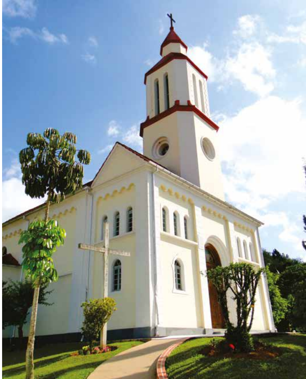
Terceira e atual igreja, construída em 1951, é inspirada em projeto trazido da Alemanha (Foto Adriano Fernandes)
