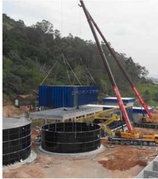
Etapas da Obra da ETE Figueira
