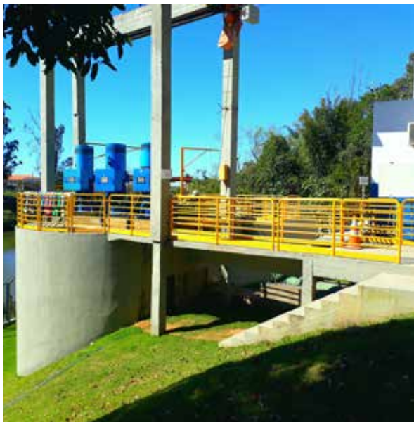
Sistema de Abastecimento de Água R$ 13 milhões
