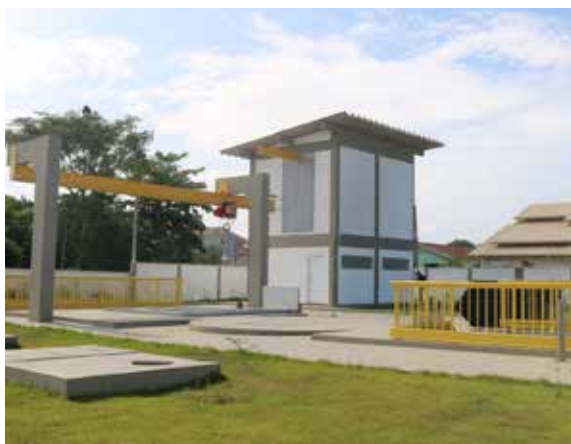
Estação Elevatória Braz e Linha de Recalque R$ 7 milhões
