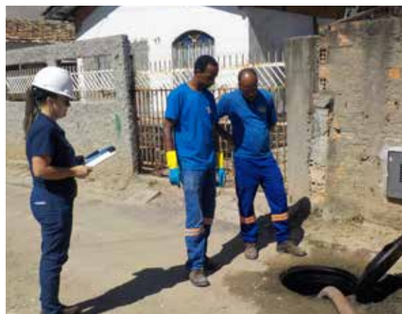
Fiscalização de Ligação Irregular de Esgoto
