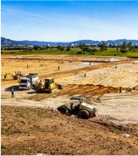
Início das Obras da ETE Figueira
