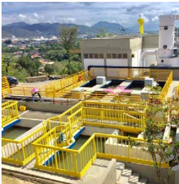
Novos Floculadores e Decantadores R$ 2,9 milhões
