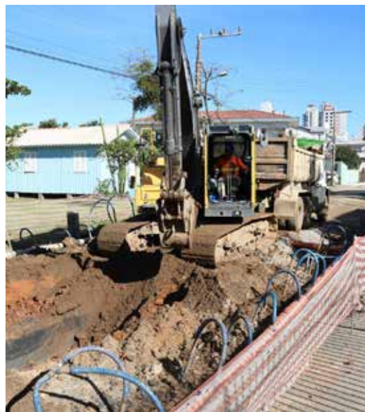
Assentamento de Redes de Esgoto
